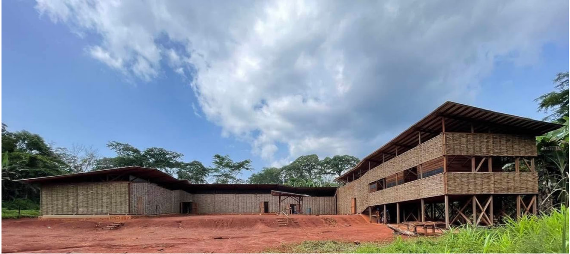
写真3：完成したズーラボットステーション
