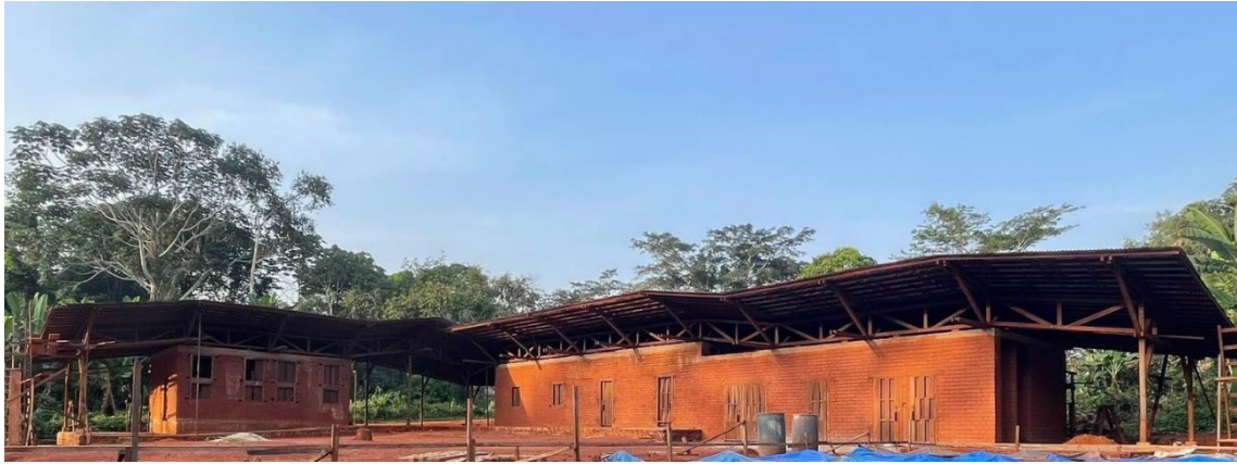
図2：建設中のズーラボット・フィールドステーション
